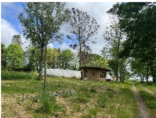
③ Petite construction réversible terre-paille + voie carrossable faisant le tour de la parcelle
